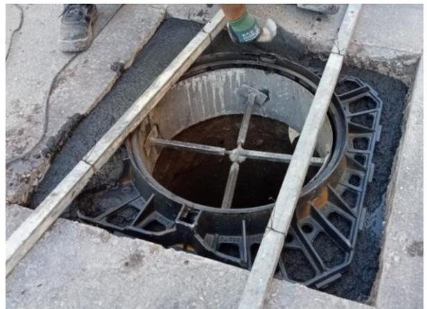
Bétonnage réalisé en prêtant attention au remplissage des cavités du cadre.
